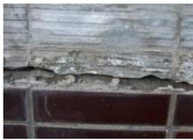
外壁タイルの剥落とコンクリートのひび割れ
