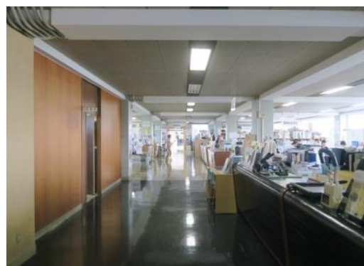
省エネで部分消灯の蛍光灯照明
