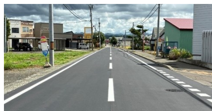
舗装修繕工事の施工事例 (道路新設改良事業)
