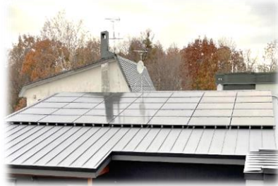
太陽光発電設備等設置事例 （脱炭素・環境対策事業）
