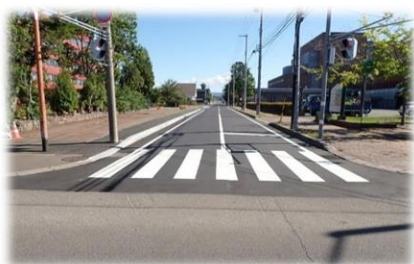
舗装修繕工事の施工事例 （道路新設改良事業）
