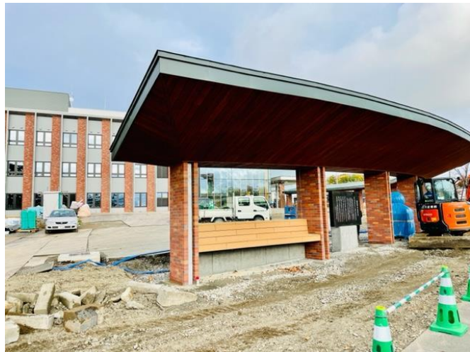
【バス待合スペースの工事の状況】
