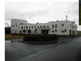
栗沢下水道管理センター
