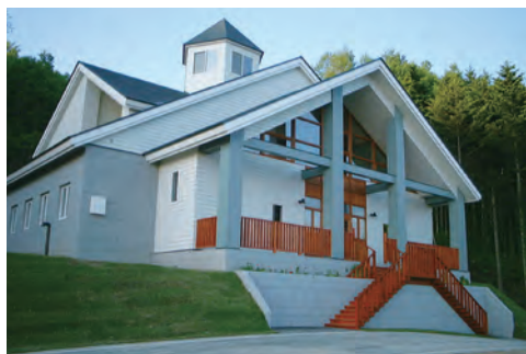
▲ テレワークセンター（コア棟）
