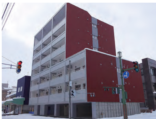
▲「まちなかで子育て」を目指して新築された市営住宅（2条団地）
