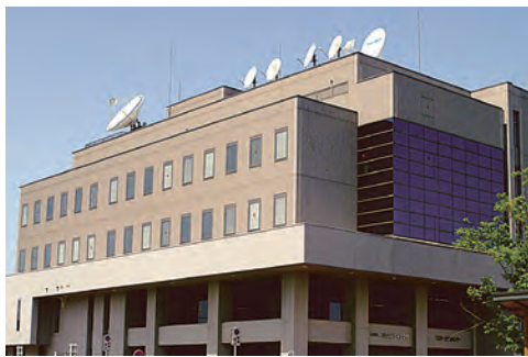
▲ 自治体ネットワークセンター
