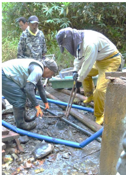
(左) 古くなったパイプの部品交換
