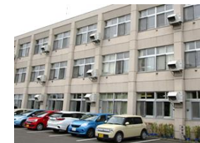
室外機設置イメージ
