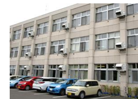
室外機設置イメージ
