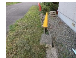
側溝整備要望 （側溝補修）
