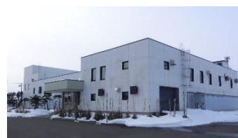
栗沢下水道管理センター
