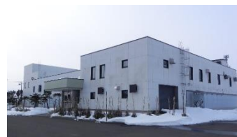
栗沢下水道管理センター
