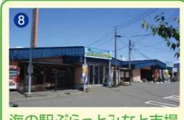
道の駅むかわ四季の館 温泉とホテルのほか、プールや食堂、図書室、地場産品が並ぶ物産館などが併設する複合施設。
