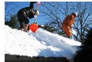
屋根の雪下ろし作業>
