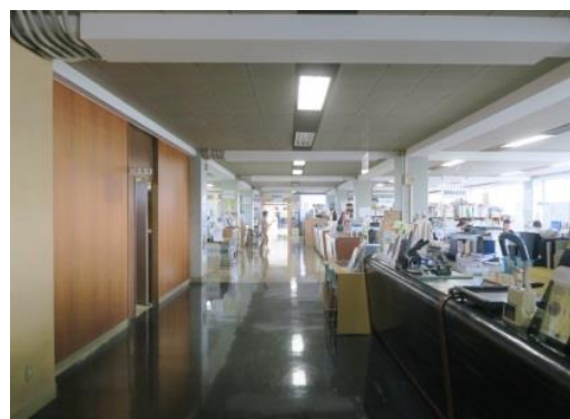
省エネで部分消灯の蛍光灯照明
