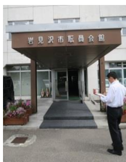
段差のある出入口
