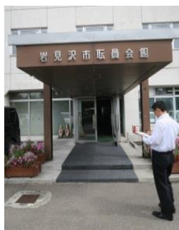
段差のある出入口
