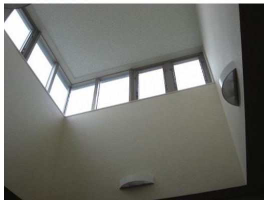
自然通気が可能な吹き抜けの事例
