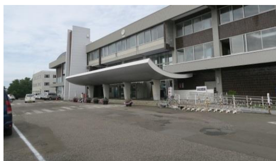
庇のないアプローチ
