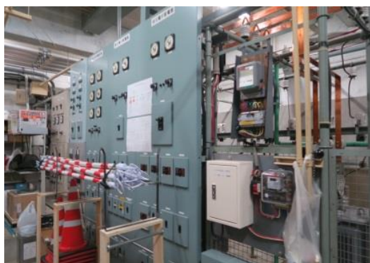
旧式の電気設備
