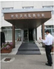
段差のある出入口
