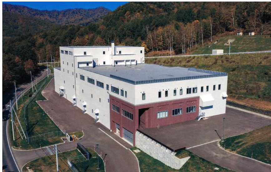
新桂沢浄水場 (三笠市西桂沢) 令和3年3月16日供用開始
