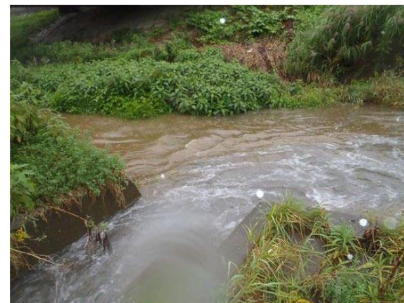
平成27年9月2日 No.3吐口放流状況
