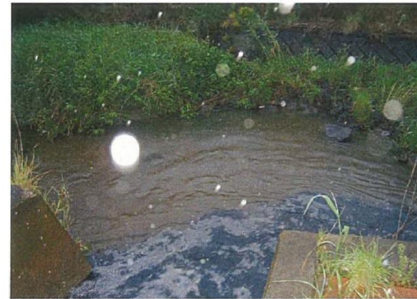
平成15年8月24日 No.3吐口放流状況
