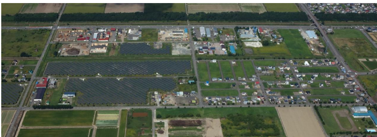
上幌向工業団地
