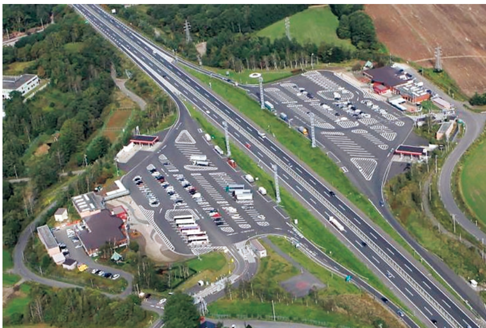
写真 4-2-2 道央自動車道輪厚パーキングエリアとスマートインターチェンジ（出典：北広島市）
