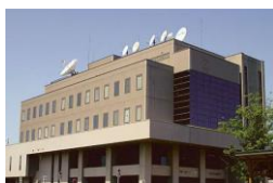
(自治体ネットワークセンター)
