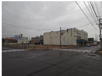
現況写真(南側)
