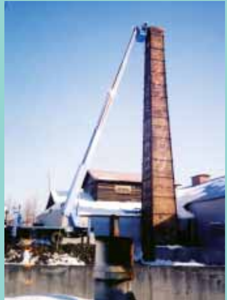
平成12年に北海道農材工業(株)栗沢工場の煙突が解体される様子を撮影しました。
