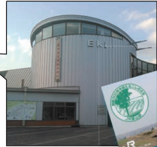
9:26 丸い形が印象的なカルチャープラザ EKI に併設された栗山駅 (明治 26 年開業)
