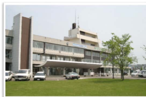
建替えとなる現市役所庁舎
