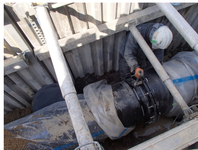
耐震管(φ600)布設工事の様子
