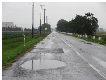
道路部分補修(水たまり解消)
