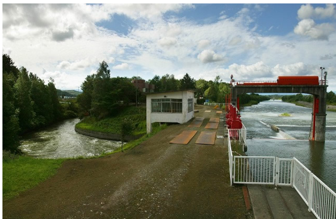
かんがい用水の水源となる北海頭首工
