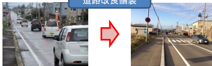
道路改良舗装
