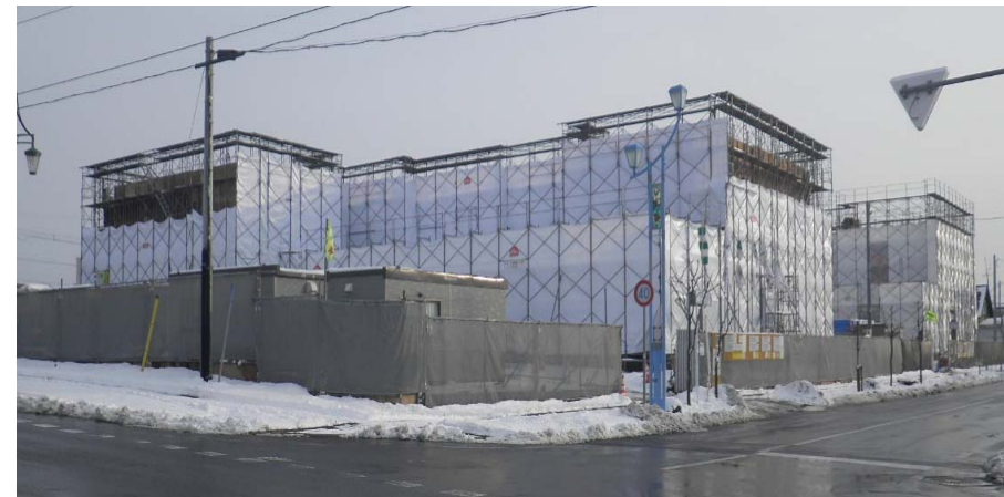
建替え工事中の栗沢栄団地
