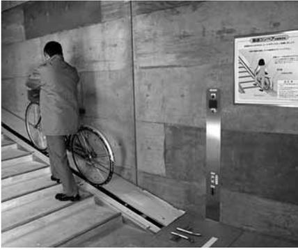
自転車を置くと、センサーが感知して自動で動くスロープ
