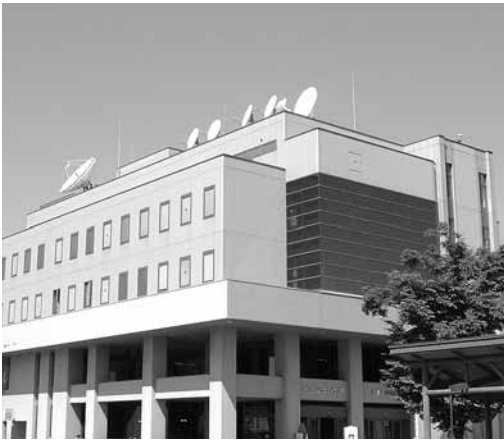
自治体ネットワークセンター
