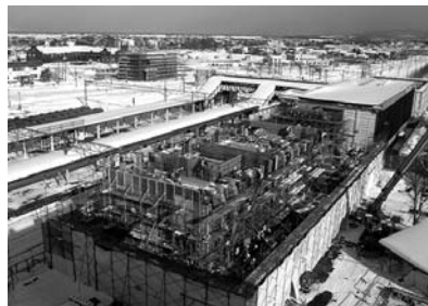
有明連絡歩道、複合駅舎、駐輪場の整備が進む
