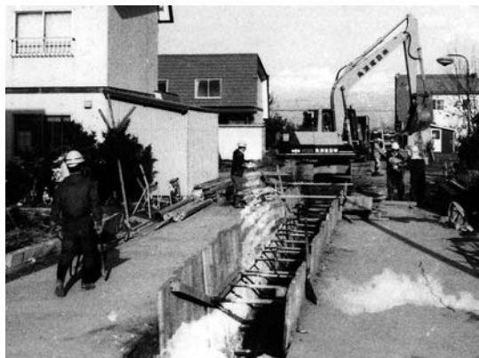
住宅地にも進んだ下水道管の埋設
