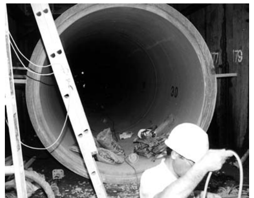
直径2 mもの下水道管の埋設
