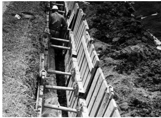
安定した水を供給する配水管の埋設
