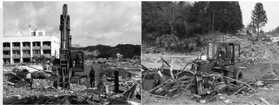
災害復旧のためには、道路の復旧が必要になりますので、津波によって流された家屋などのがれきをよけながら、道路を掘り出しています。(がれき除去作業する岩見沢駐屯地の自衛隊員)
