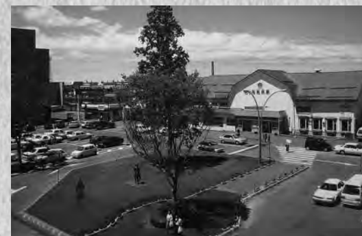
長く市民に愛され続けていた3代目の岩見沢駅舎
