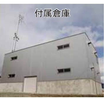
付属倉庫 新庁舎と消防の栗沢支署の間に位置し、水防資材や非常用照明器具、非常食、毛布などを常備しています
