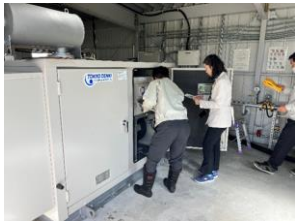
発電機準備の様子
