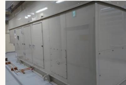
ライフラインがストップしても防災庁舎として機能するために、7日間の自立稼働を可能とする非常用発電設備や給排水設備を設置
