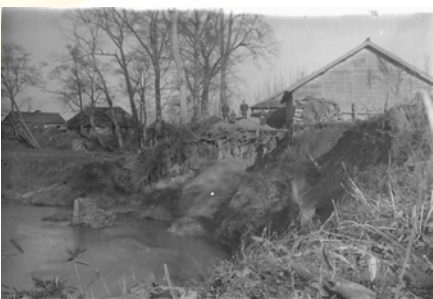
大正14年12月 堤防が壊れた際に被害状況の記録のため撮影された写真
