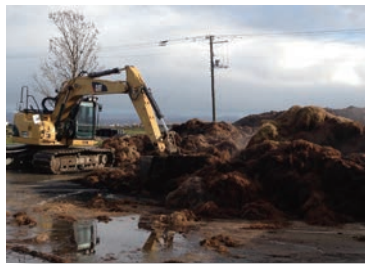
脱水肥料の管理状況
