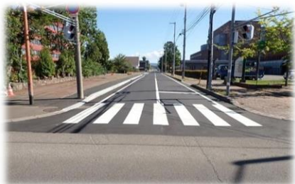
舗装修繕工事(市道9条線)の施工事例 (道路新設改良事業)
